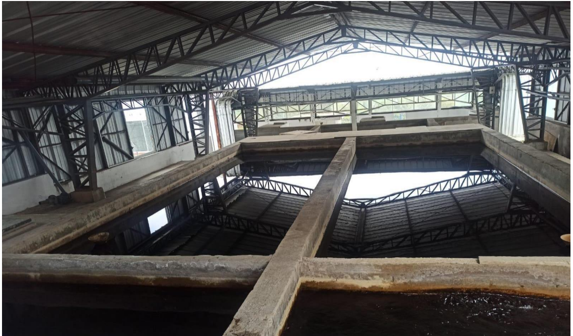
Ilustración 3. Sitio de Captación del agua de consumo humano del Cantón Cevallos que abastece a la población.
