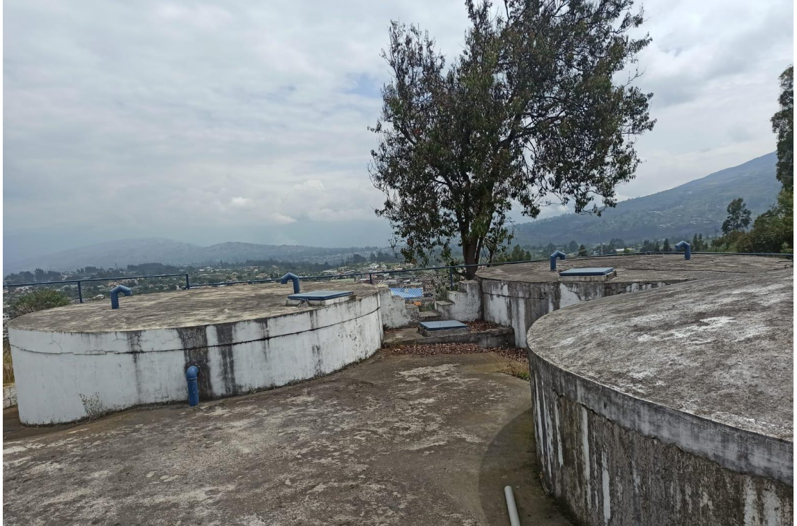
Ilustración 1. Tanques de distribución del agua de consumo humano del Cantón Cevallos (sector barrio el mirador)
