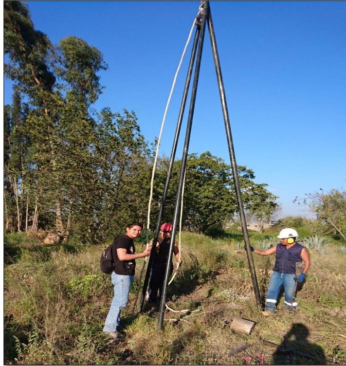
Fotografía 1. Colocación equipo SPT
