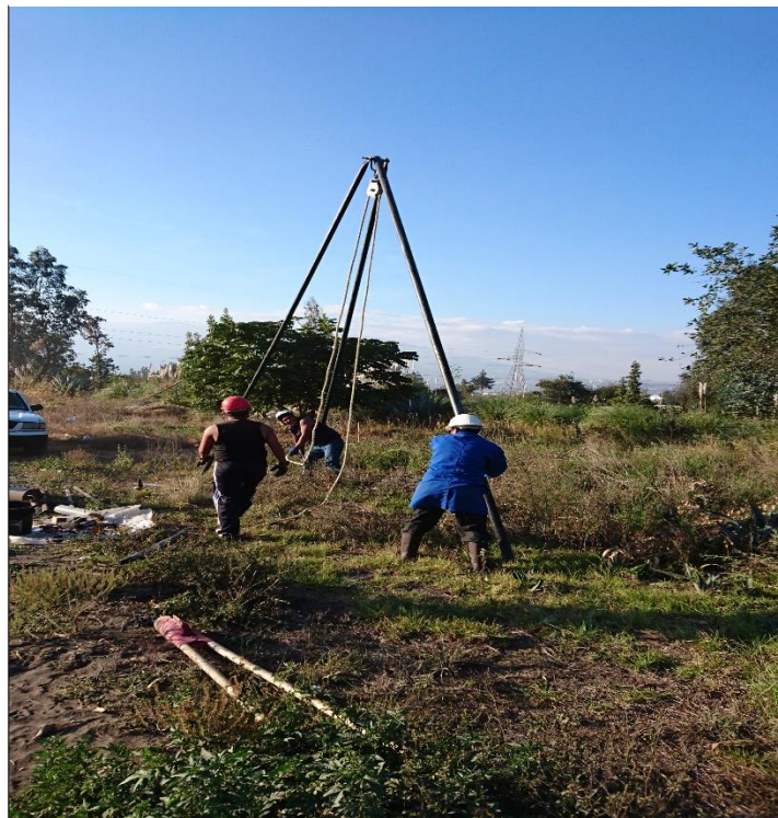
Fotografía 2. Colocación equipo SPT
