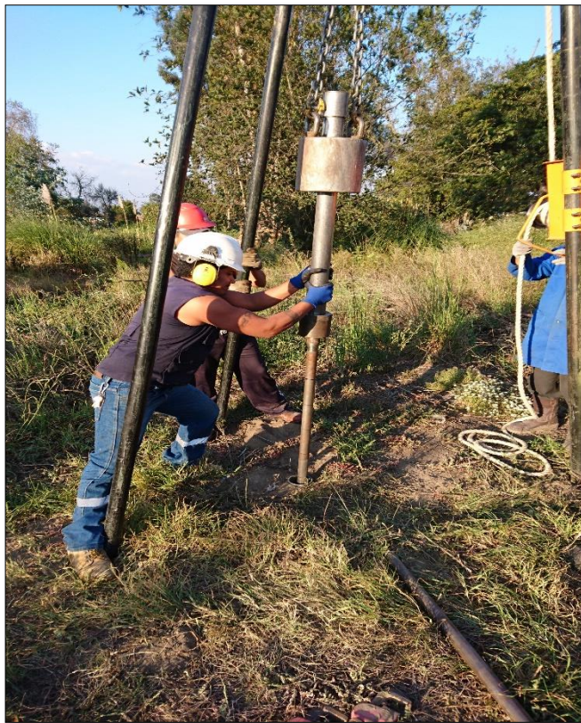
Fotografía 4. Ejecución ensayo SPT
