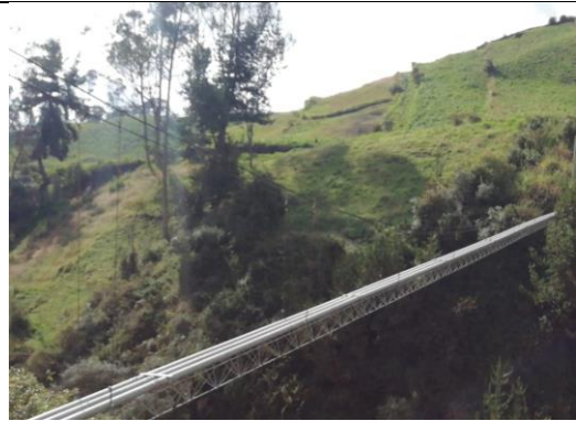
Fotografía 18: Puente para cruce de tuberías
