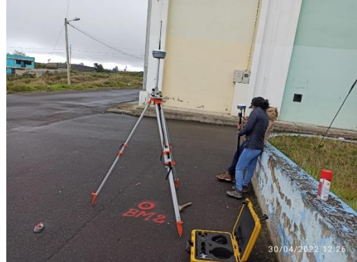
Fotografía 36: Instalación de GPS RTK para levantamiento de puntos de referencia – BM2
