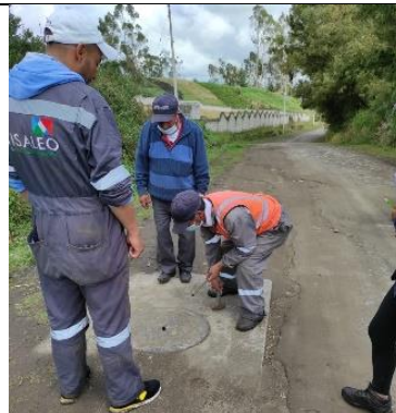
Fotografía 24: Inspección de Válvula de aire
