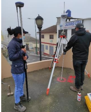
Fotografía 35: Instalación de GPS RTK para levantamiento de puntos de referencia – BM1
