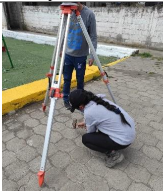
Fotografía 37: Instalación de GPS RTK para levantamiento de puntos de referencia – BM5
