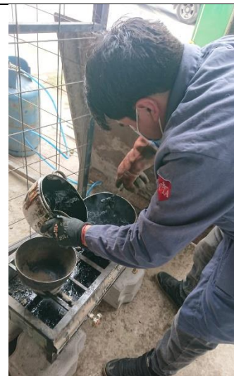
Mezcla de agregados con el bitumen
