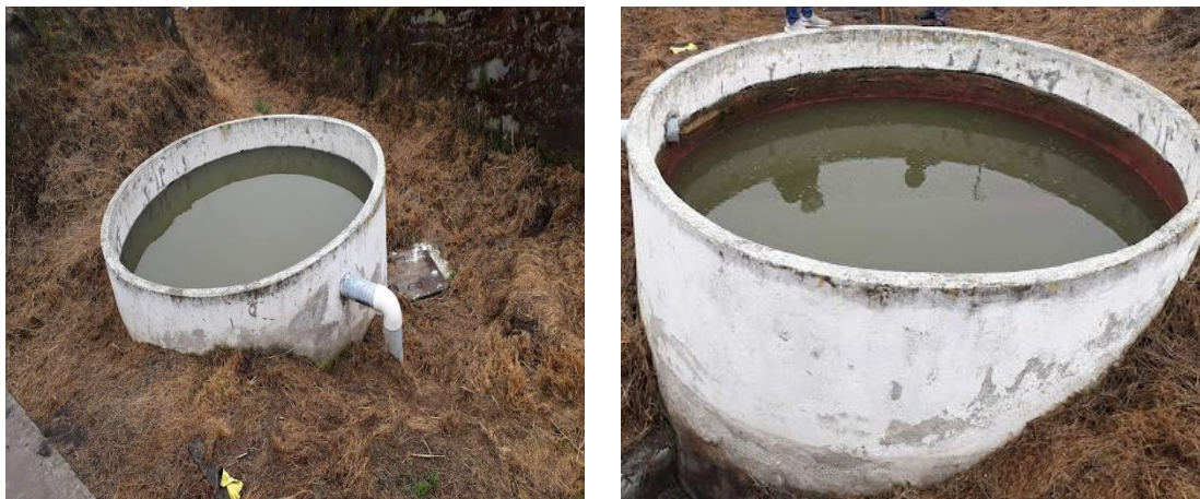
Figura 55. Estado actual del FAFA
