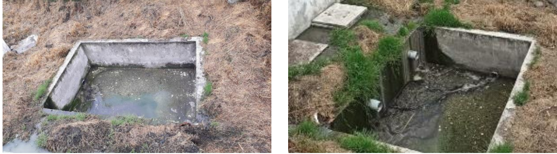
Figura 56. Estado actual del lecho de secado de lodos
