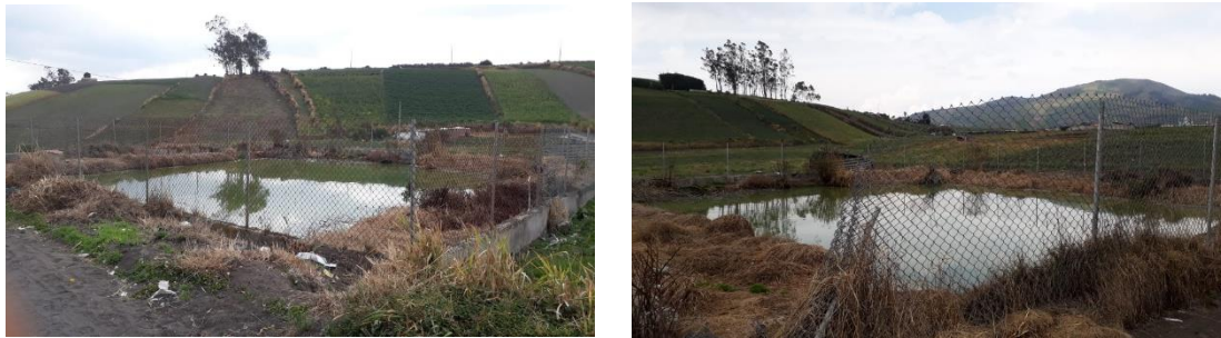
Figura 57. Estado actual del campo de infiltración
