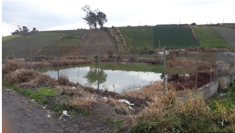
Figura 52. Campo de infiltración de la PTAR El Santuario
