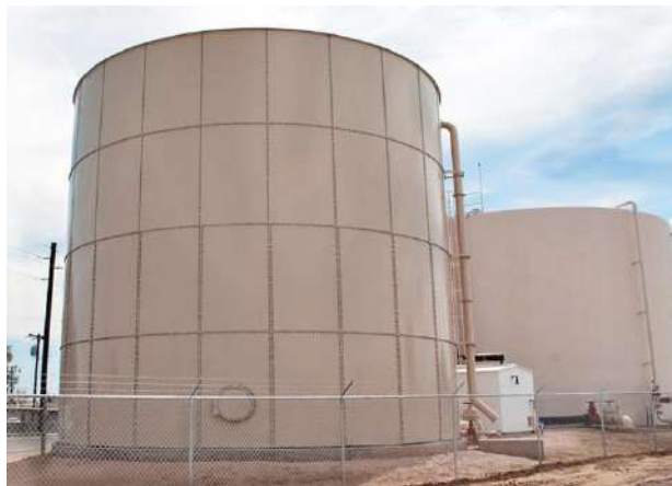
Figura 3: Tanque remachado [5].
