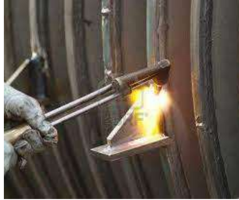
Figura 11: Limpieza con Flama (SSPC – SP4) [14].
