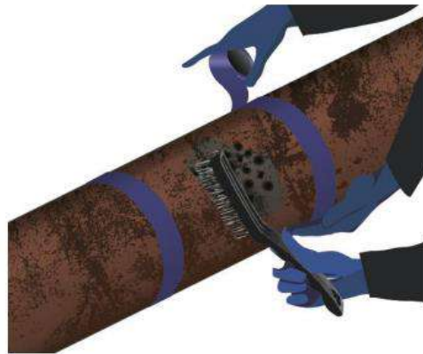
Figura 9: Limpieza Manual (SSPC – SP2) [14].
