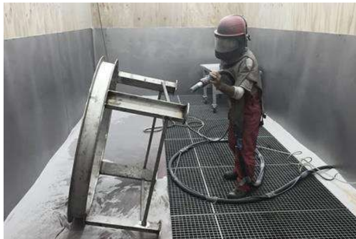
Figura 17: Aplicación de Sandblasting [15].
