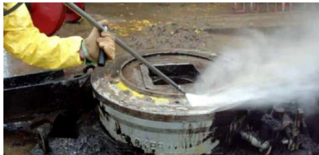
Figura 12: Limpieza por Hydroblast (SSPC – SP6) [14].
