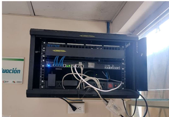
Figura 93. Rack de comunicaciones Elaborado por: El Investigador
