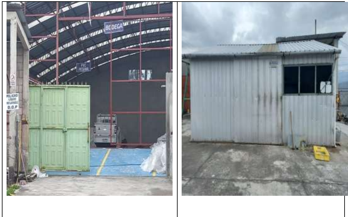
Figura 11. Instalaciones externas de la empresa “PRODU PLASTIC”
