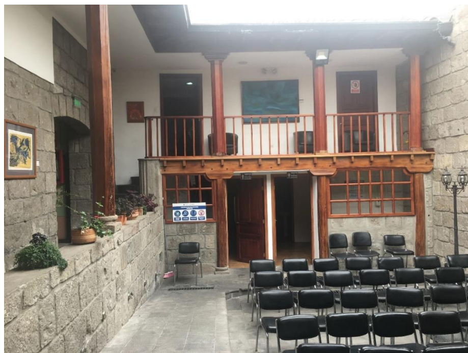
Figura 27: Patio interior 2, con sistema soportante de madera – Museo Edmundo Martínez
