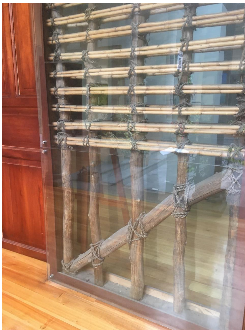
Figura 25: Estructura de pared de bahareque - Museo Edmundo Martínez
