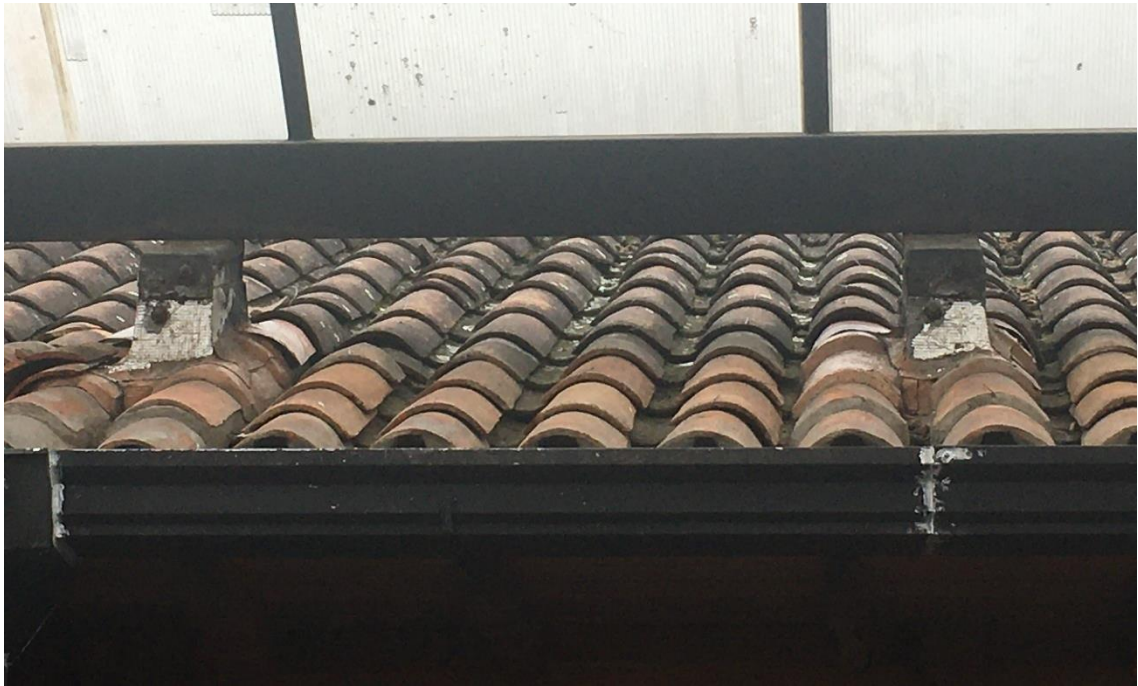
Figura 20: Anclaje de cubierta desmontable de policarbonato
