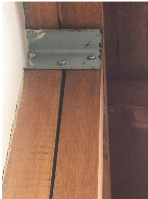
Figura 19: Reforzamiento con utilización de placas
