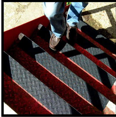
Figura 40. Sistema antideslizante para escaleras fijas [49]
