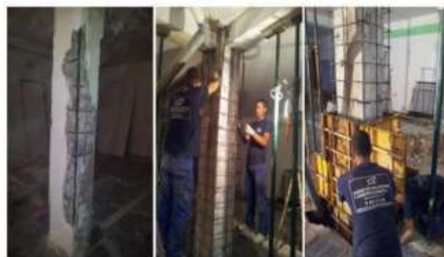
Figura 27: Encamisado de hormigón armado
