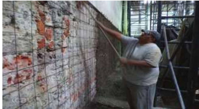
Figura 26: Enchapado de Mampostería
