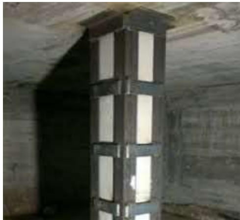
Figura 29: Reforzamiento con platinas metálicas
