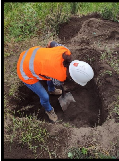
Figura 21: Pozo a cielo abierto
