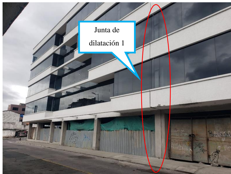
Fig. N° 32: Fachada frontal de la edificación
