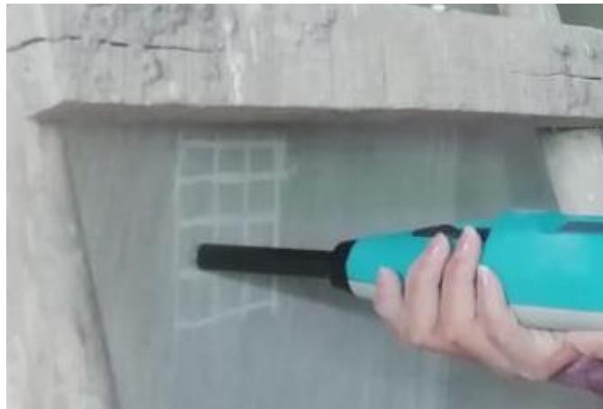
Fig. N° 39: Ensayo esclerométrico con la norma ASTM C805
