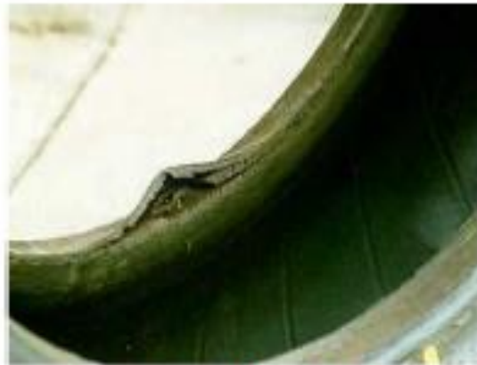
FIGURA 7. Daños en el aro
