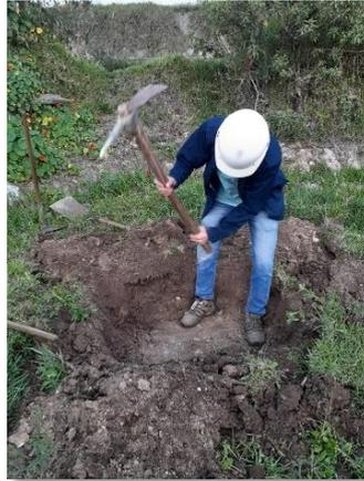
*Figura 22: Pozo a cielo abierto, M1-Rumipamba de Navas.
