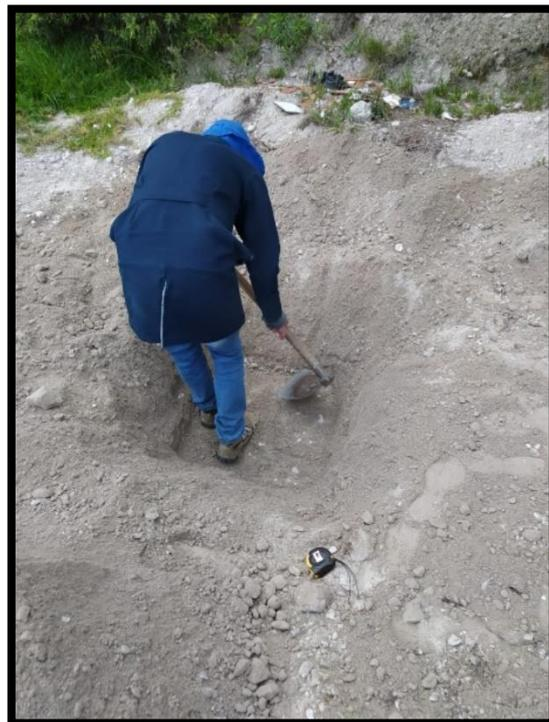
*Figura 61: Excavación de la calicata del punto 2 de la vía Yanayacu*
