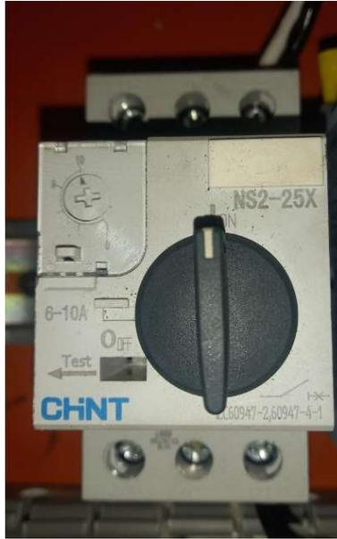
**Figura 25.** Guardamotor de 6 a 10 Amp CHNT.
