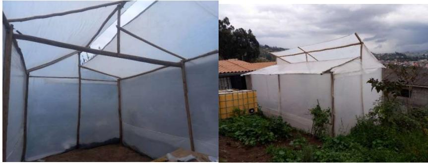
**Figura 81.** Invernadero tipo Capilla con ventana cenital y ventanas laterales.
