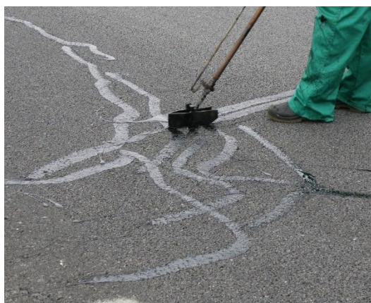
Figura 7. Sellado de grietas
