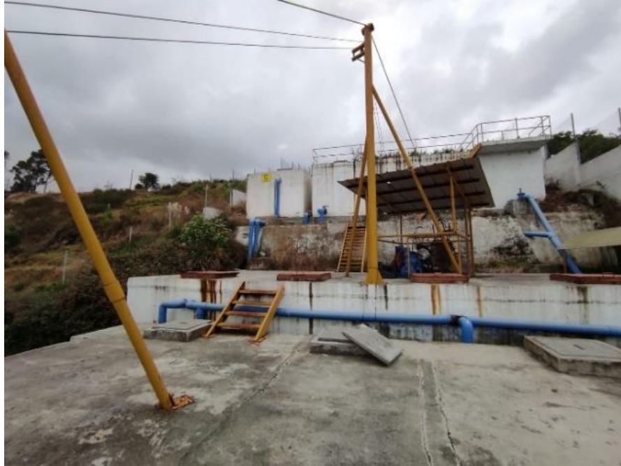
Figura 21 Planta de tratamiento de aguas residuales “Centro Cantonal”
