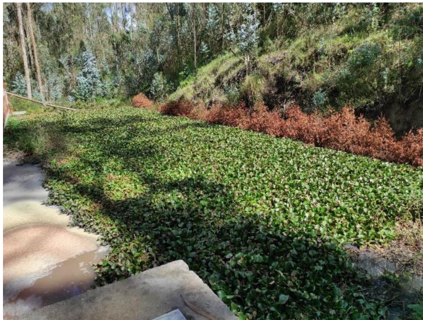
Figura 23 Tanques biodigestores (Lechuguines) - Descarga de la Red Tisaleo
