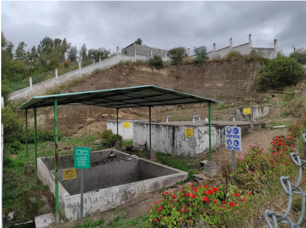
Figura 24 Planta de tratamiento de aguas residuales "San Juan"
