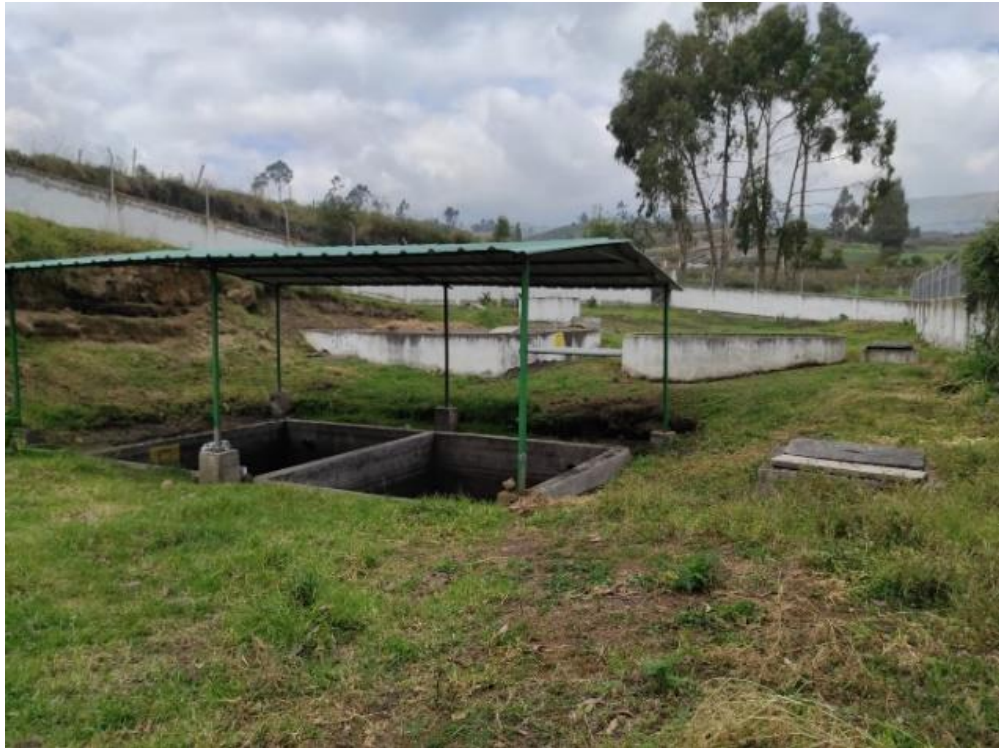
Figura 20 Planta de tratamiento de agua residuales "Chilco la Esperanza"
