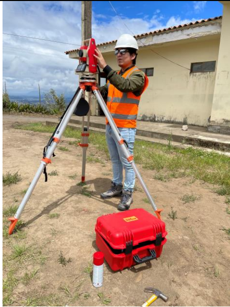
Ilustración 15. Levantamiento Topográfico. Fuente: Autores
