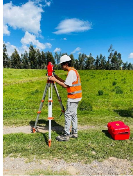
Ilustración 14. Levantamiento topográfico. Fuente: Autores
