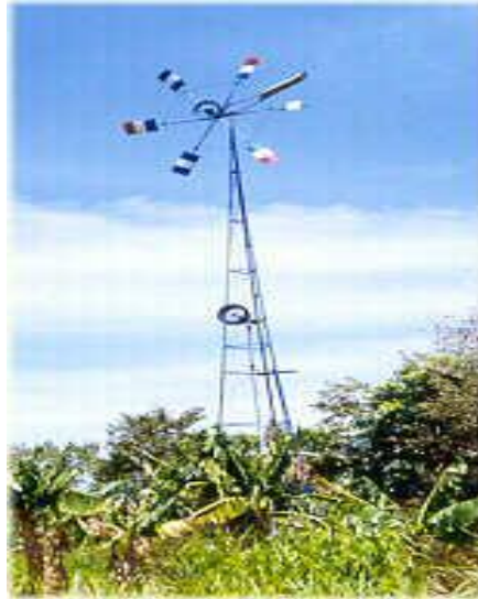
Fig. 2.6 Sistema de bombeo de manufactura informal.
