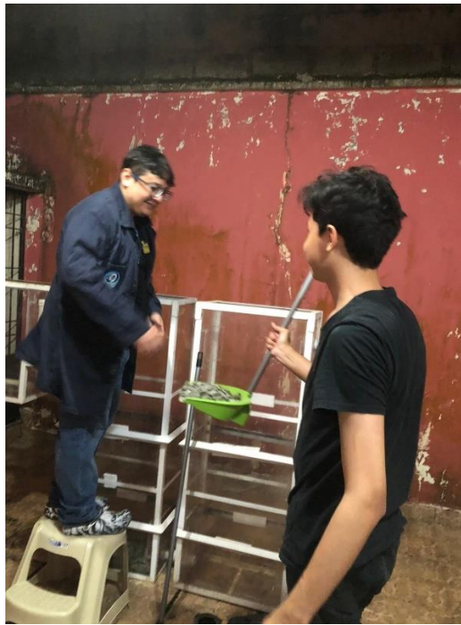
Fig. 21 Colocación de materiales filtrantes.
