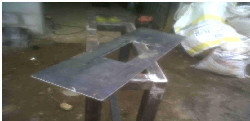
Figura 6.23 Construcción de la bancada y placa base (Fuente: El autor)
