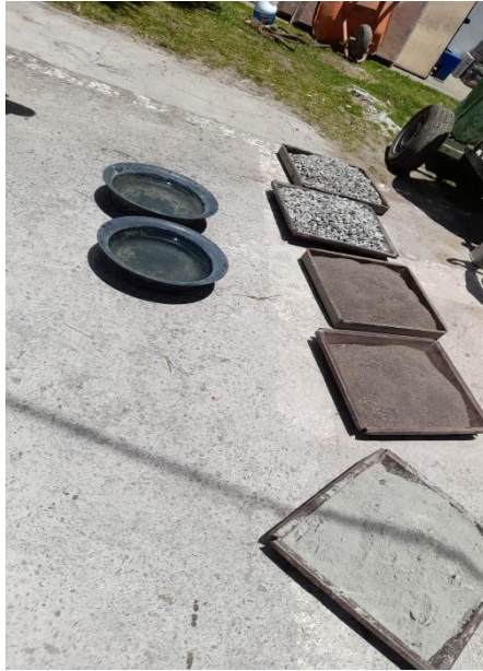
Fotografía 19. Materiales para elaborar la mezcla de concreto
