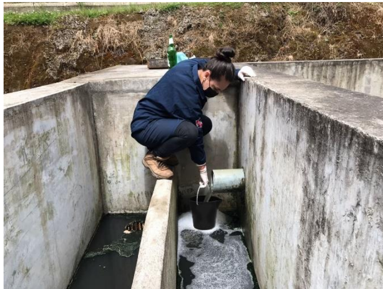
Imagen 13. Medición del caudal de salida de la PTAR. Fuente: Autora
