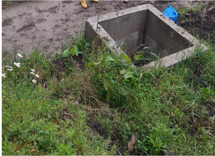
Imagen 32. Tanque repartidor de caudales con abundante vegetación Fuente: Autora
