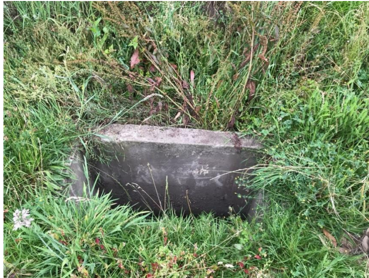
Imagen 20. Trampa de grasas cubierta de vegetación. Fuente: Autora
