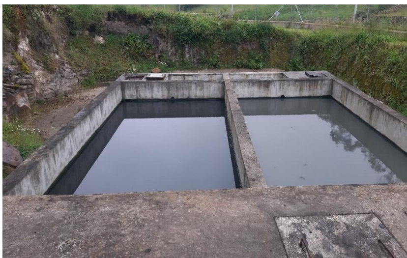
Imagen 24. Filtros aerobios de flujo ascendente de la PTAR. Fuente: Autora
