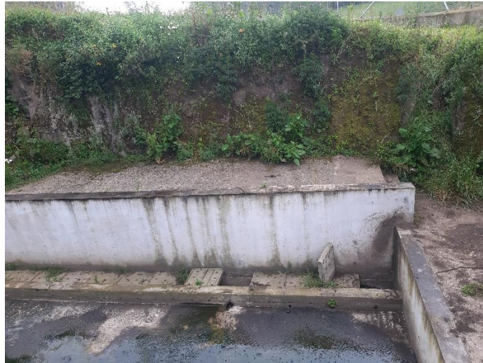
Imagen 33. Infraestructura en obra gris Fuente: Autora
