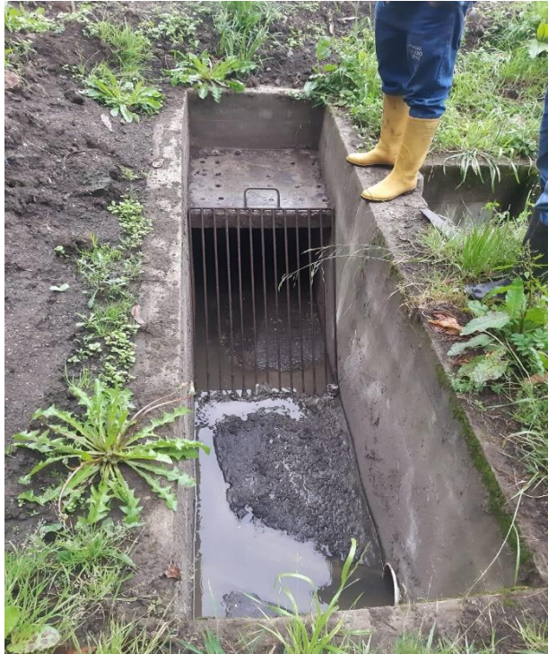
Imagen 18. Rejilla ubicada de forma correcta. Fuente: Autora
