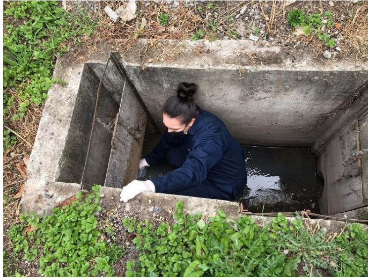
Imagen 12. Medición del caudal de ingreso a la PTAR. Fuente: Autora
