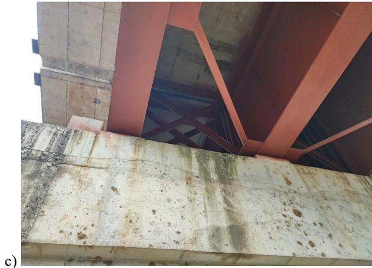
Figura 20. Dispositivos de restricción al movimiento transversal: a) Viga sobre apoyo de neopreno, b) Traba sísmica en estribo, c) Traba sísmica en pila central
