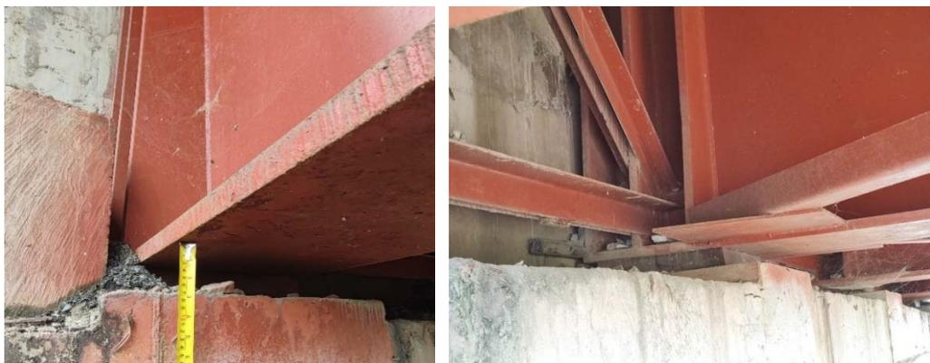
Figura 25. Apoyos elastoméricos no anclados puente en estudio.
