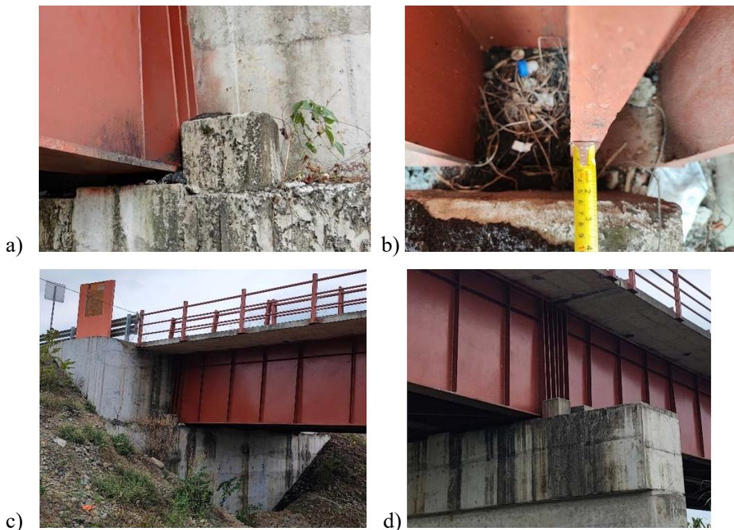
Figura 32. Trabas sísmica caso de estudio. a) Traba sísmica tipo, b) Abertura (gap), c) Traba en estribo, d) Traba en pila central
