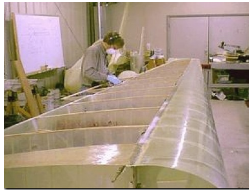
Ilustración 4. 11 Alas construidas con materiales compuestos. (Fuente: Autora)
