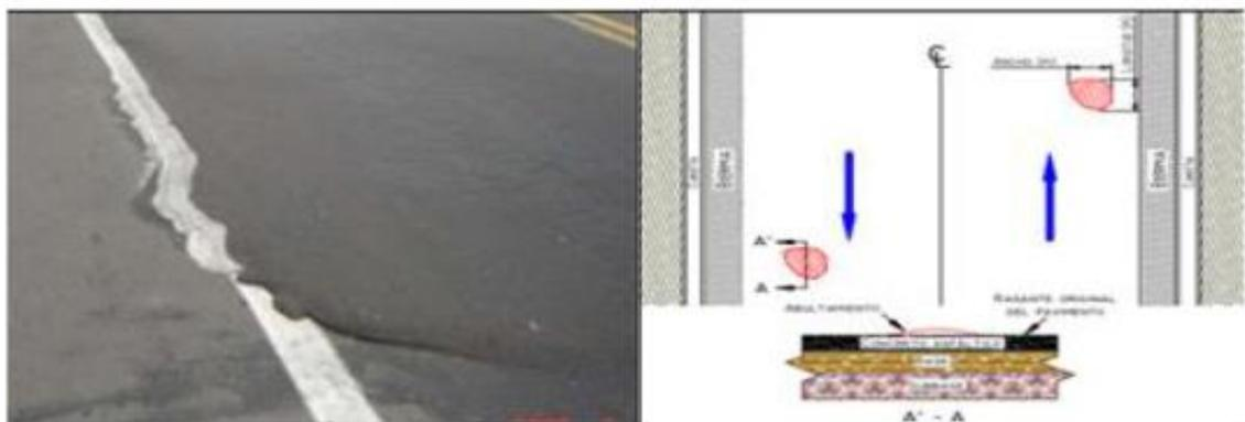
*Fig. 15.* Daño por abultamiento [19].
