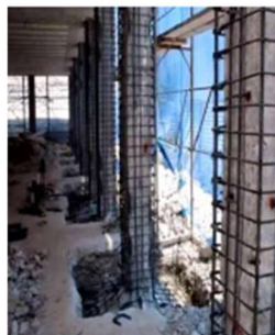
Figura 6 Encamisado en columna de hormigón armado
