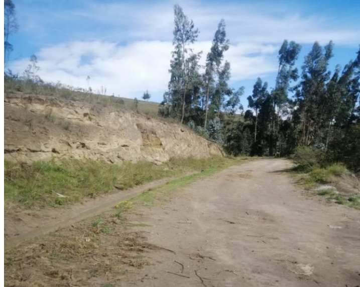
Estado actual – Inicio de la vía
