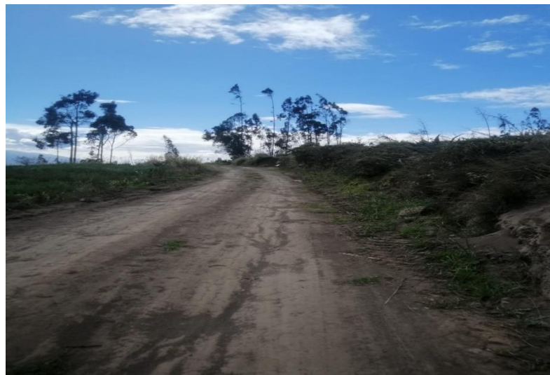
Estado actual – Final de la vía
