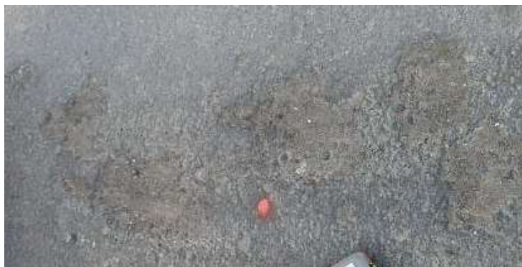
Gráfico 25. Falla por Desprendimiento de agregado
