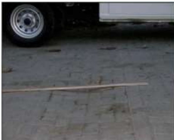
Gráfico 28. Falla por depresiones, pavimento articulado.
