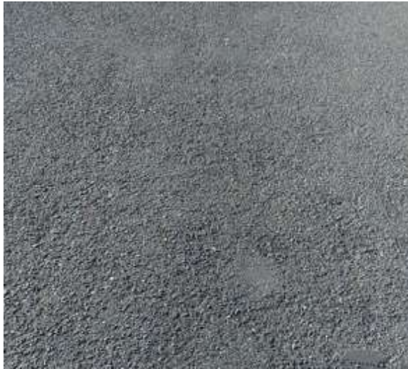
Gráfico 18. Falla por agregado pulido
