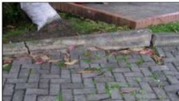
Gráfico 34. Falla por fracturamiento de confinamiento externos
