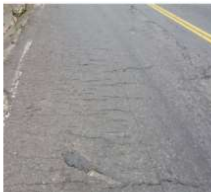
Gráfico 23. Falla por grietas parabólicas
