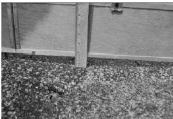
Gráfico 21. Falla por ahuellamiento
