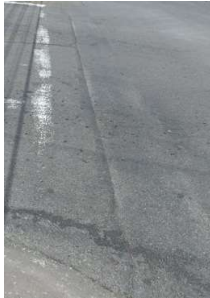
Gráfico 13. Falla por grieta de reflexión en junta
