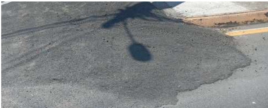
Gráfico 9. Falla por abultamiento.
