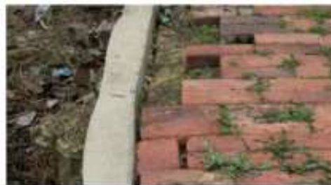
Gráfico 31. Falla por desplazamiento de borde, pavimento articulado.
