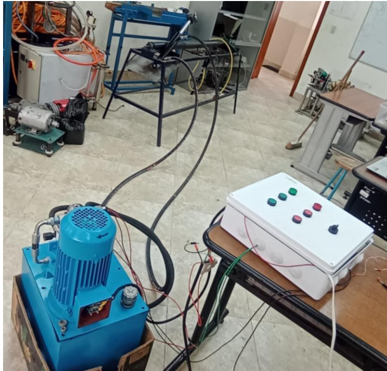
Figura 66. Pruebas de funcionamiento de la máquina.
