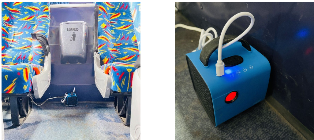
Figura. 28 Sistema de ozonificación instalado. Elaborado por el investigador.
