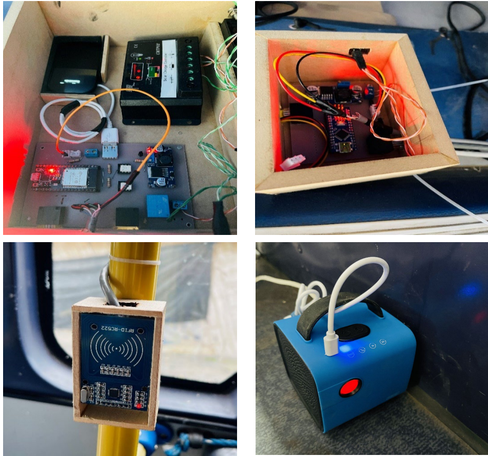
Figura. 30 Verificación visual del funcionamiento del sistema. Elaborado por el investigador.
