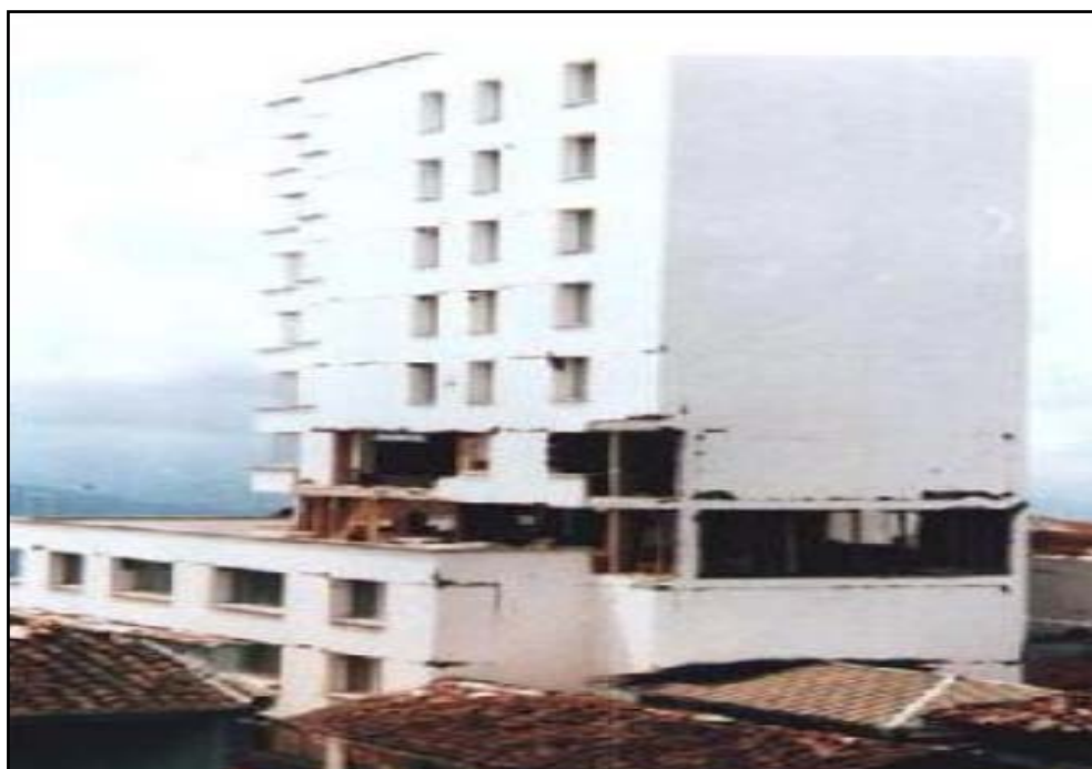
Gráfico N° 59: Falla de edificio por cambio brusco de rigidez
