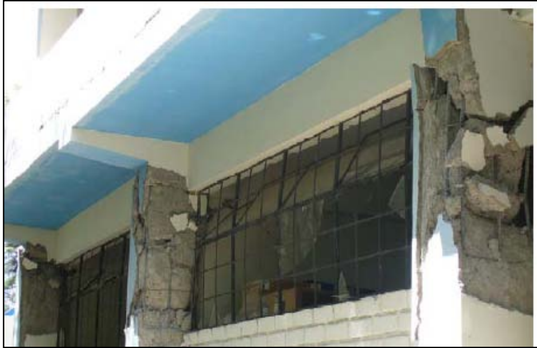
Gráfico N° 62: Fallas por columna corta tomadas de problemas estructurales por la interacción tabique pórtico ante acciones sísmicas de Roberto Aguiar
