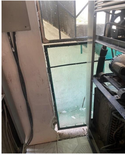
Los cables eléctricos están descubiertos y sueltos
