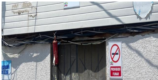
Los cables eléctricos están descubiertos y sueltos
