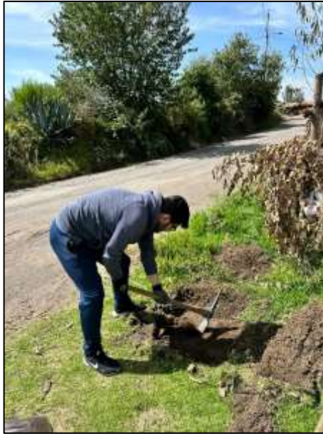
Figura 19: Excavación a cielo abierto Autor: Alvaro David Estrella López
