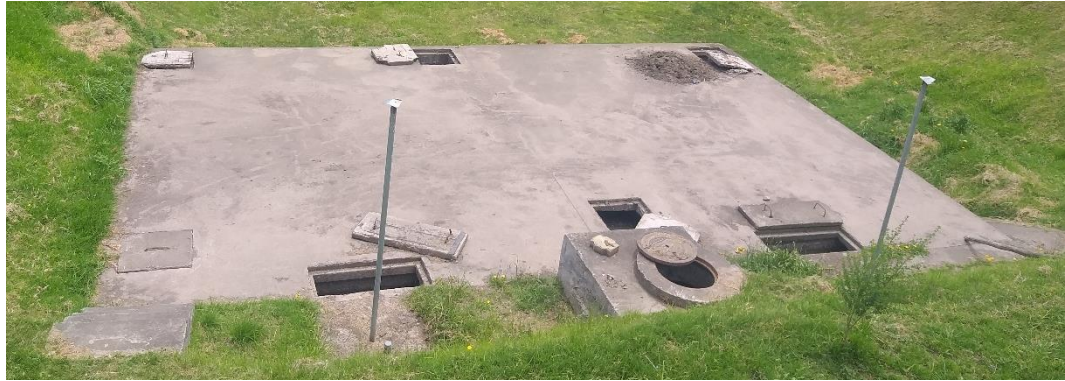
Figura 19. Reactor Anaerobio de Flujo Ascendente
