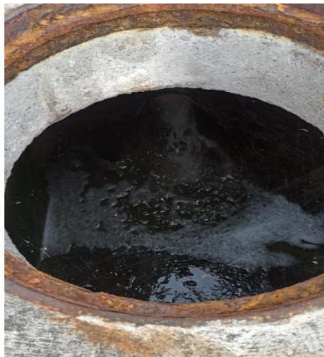
Figura 26 Tubería de Salida
