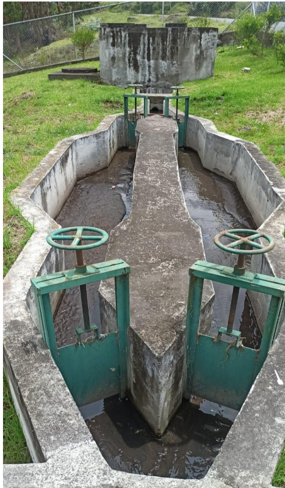
Figura 15 Desarenador
