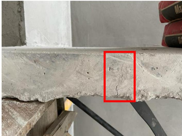
**Gráfico 48.** Agrietamiento del hormigón – viga Joist compuesta con losa maciza
