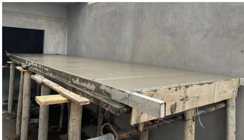
*Gráfico 32. Viga Joist compuesta con losa maciza*
