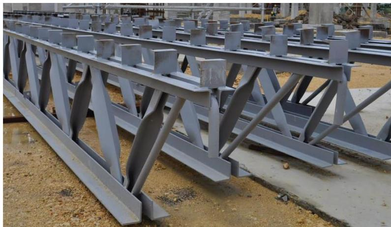
**Gráfico 11.** Construcción de viga Joist con diagonales con ángulo.
