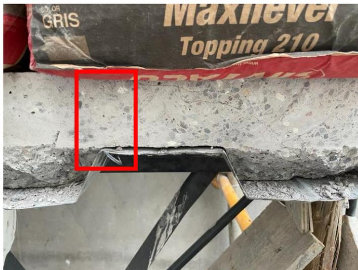
**Gráfico 49.** Agrietamiento del hormigón – viga Joist compuesta con lámina de acero
