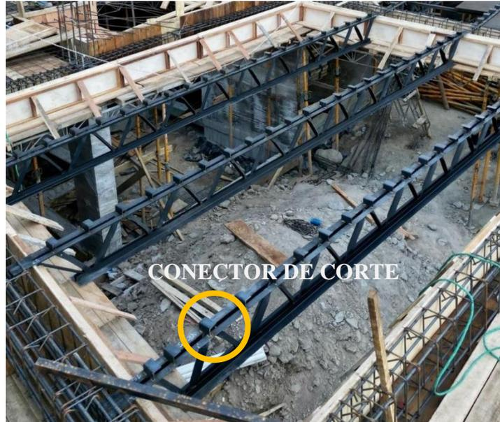
*Gráfico 16. Conector de corte tipo canal*
