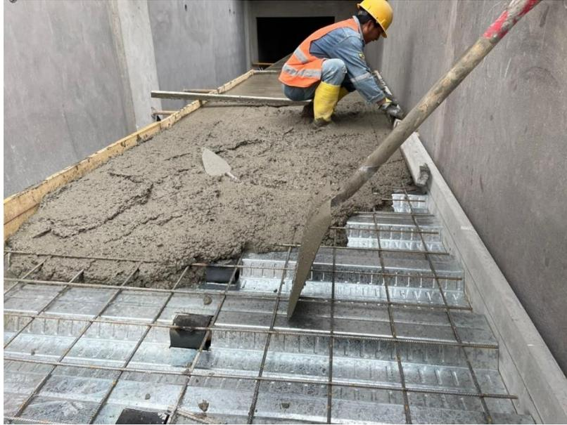
**Gráfico 33.** Viga Joist Compuesta con lámina de acero “Steel deck”
