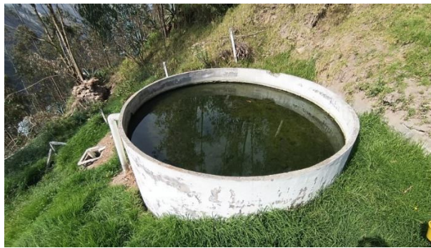
Figura 16: Filtro anaerobio de flujo ascendente (FAFA).
