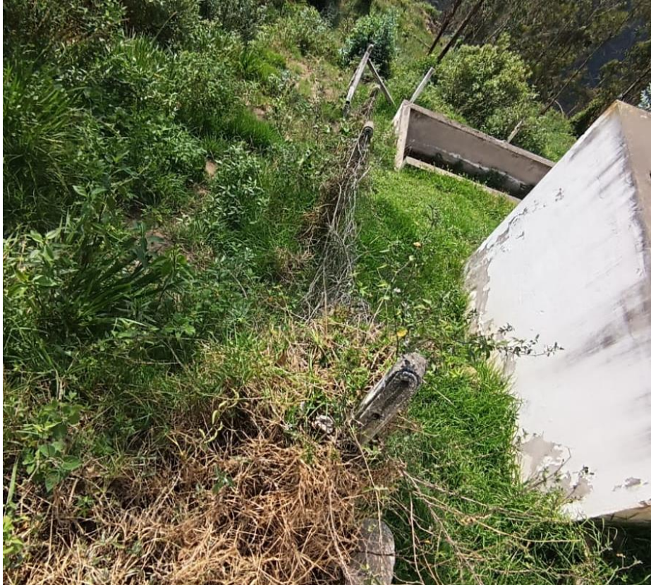
Figura 36: Ausencia de un cerramiento adecuado para la PTAR.
