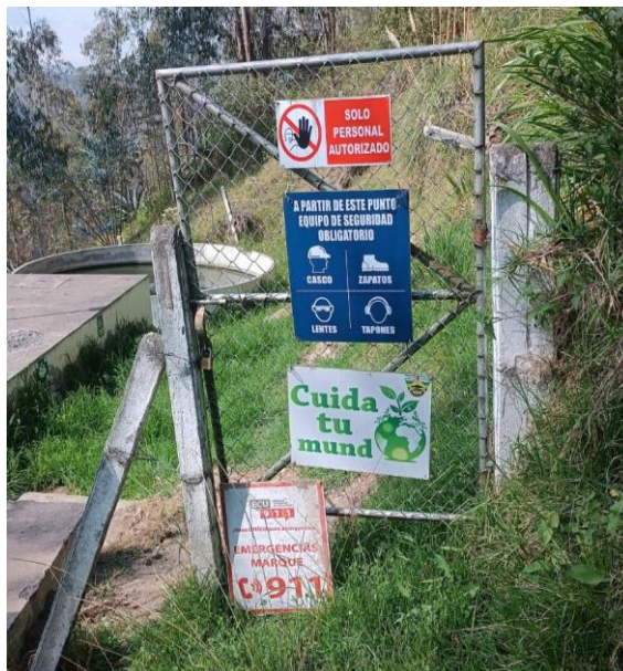
Figura 8: Falta de cerramiento en la PTAR.
