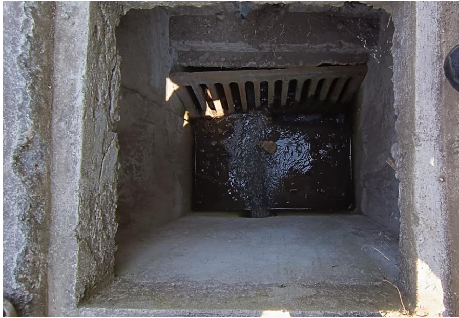
Figura 34: Vista del interior del tanque repartidor de caudales.
