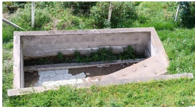
Figura 17: Lecho de secado de lodos.
