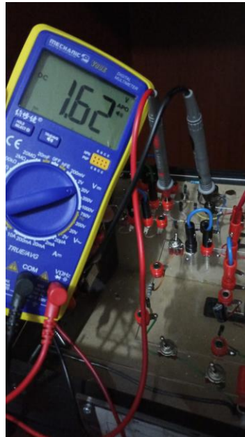
Figura 5. Verificación de funcionamiento del circuito.
