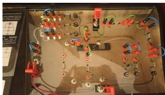
Figura 11. Tablero de circuitos vista principal.
