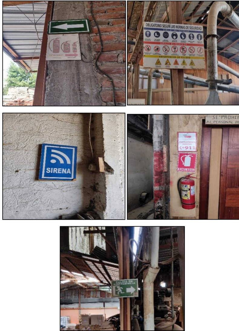
Fig. 47. Sistema de señalización
