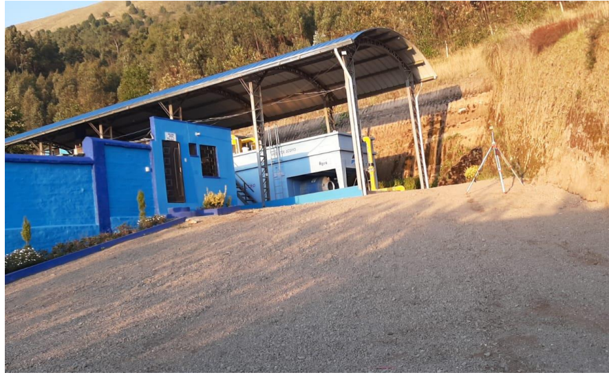
Base del RTK
