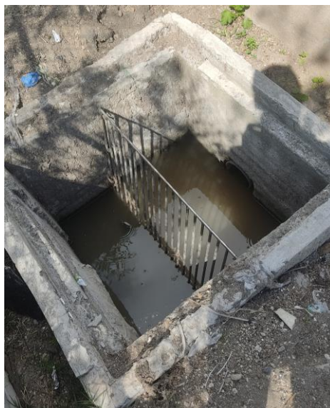
Figura 6. Caja de alivio con rejilla de cribado Fuente: Alex Fernández
