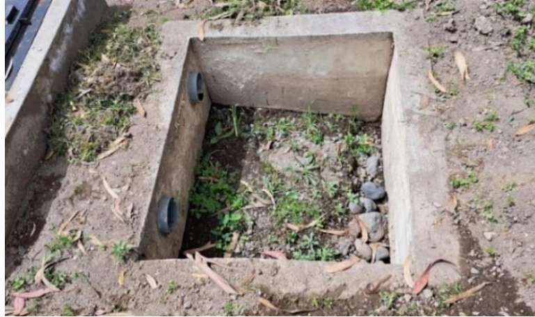
Figura 11. Lecho de secado de lodos. Fuente: Alex Fernández
