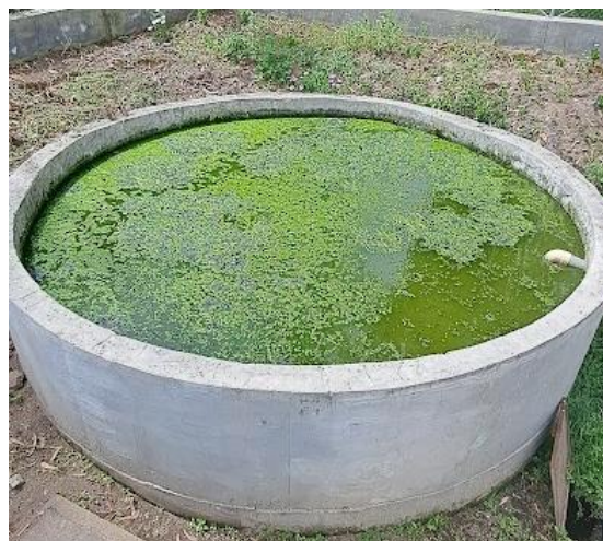
Figura 9. Filtro anaerobio de flujo ascendente. Fuente: Alex Fernández
