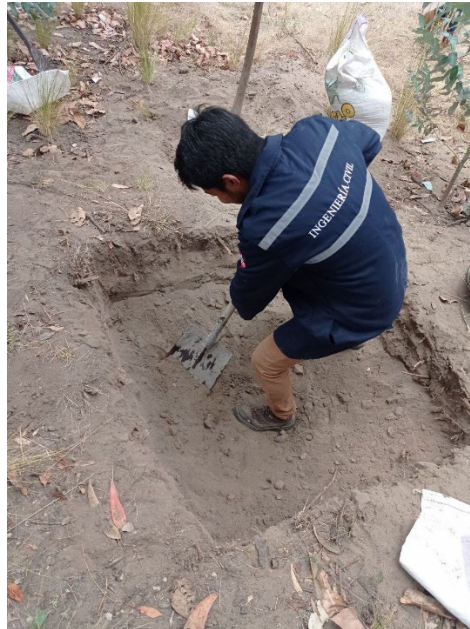
Ilustración 16 Excavación a pozo abierto
