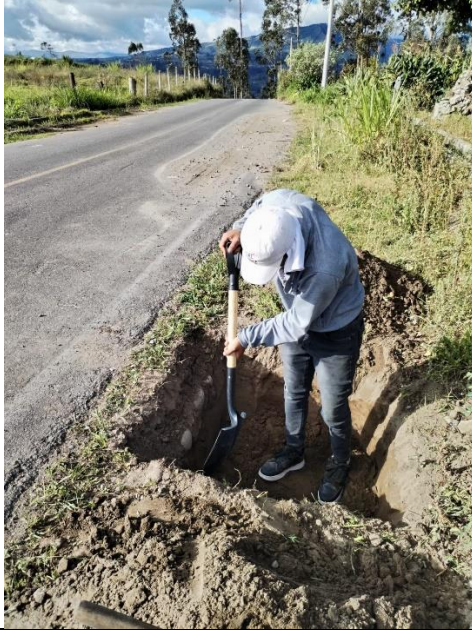
Fotografía 1. Excavación de calicatas
