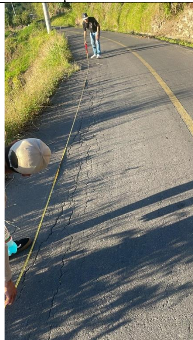
Fotografía 1. Toma de coordenadas de las faltas del PCI
