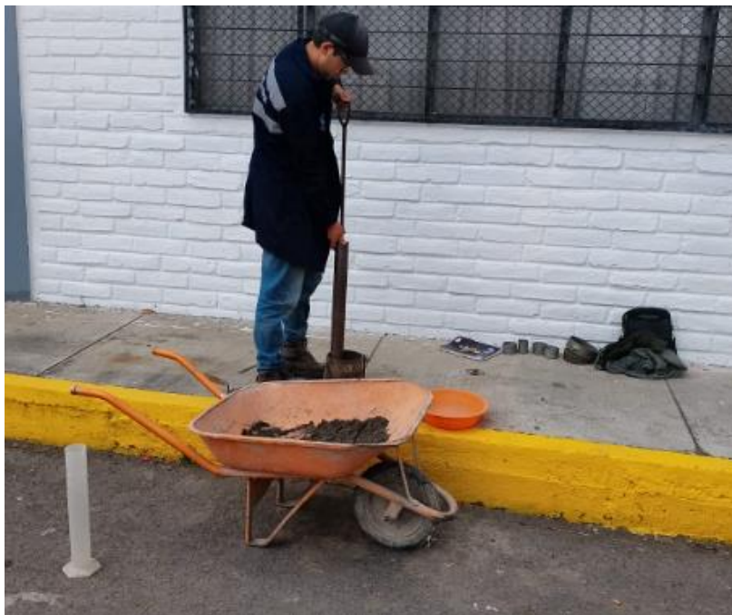
Figura 49 Compactación de suelo en el molde
