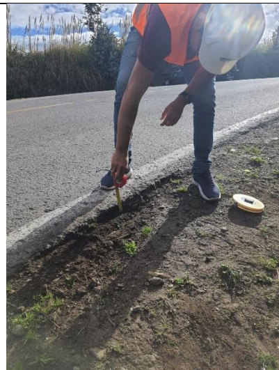
Fotografía 4. Medición del espesor del pavimento
