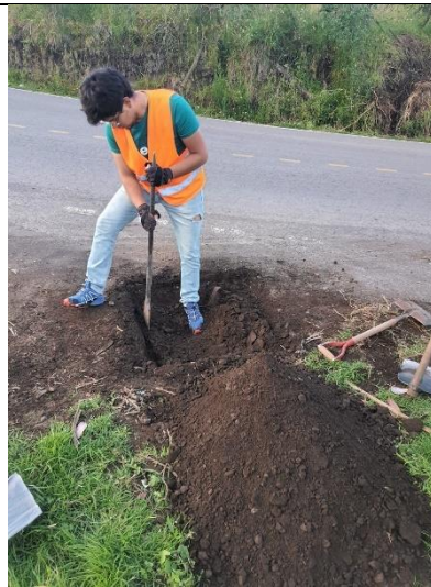
Fotografía 7. Calicatas, pozo a cielo abierto
