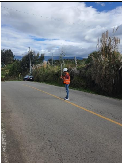
Fotografía 3. Levantamiento de la vía
