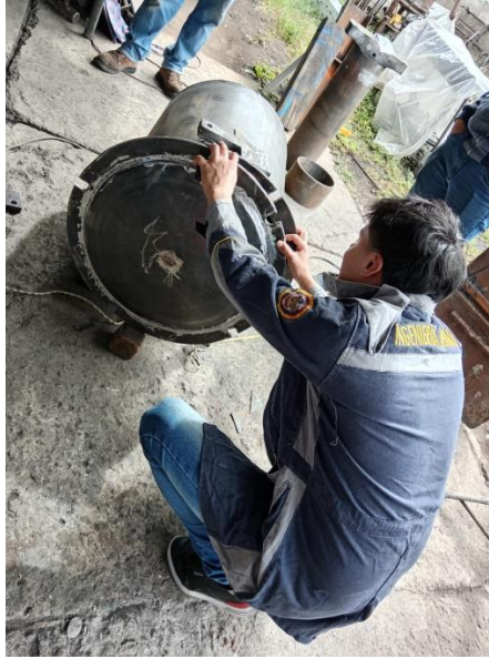
Figura 57. Alineación de la compuerta con el manto cilíndrico
