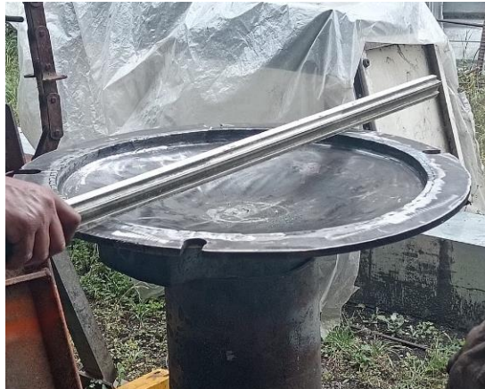
Figura 48. Enderezado y comprobación del anillo de la compuerta
