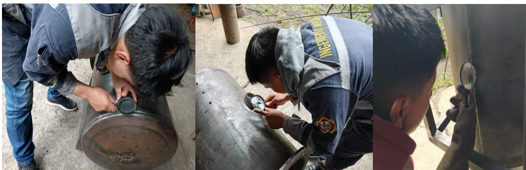
Figura 63. Inspección visual de las partes soldadas
