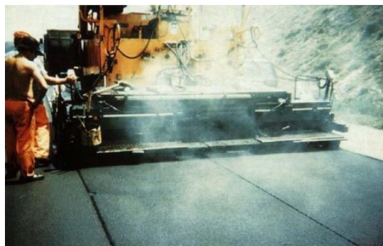
Figura 2. Extensión de una capa de slurry sobre un firme flexible en servicio
