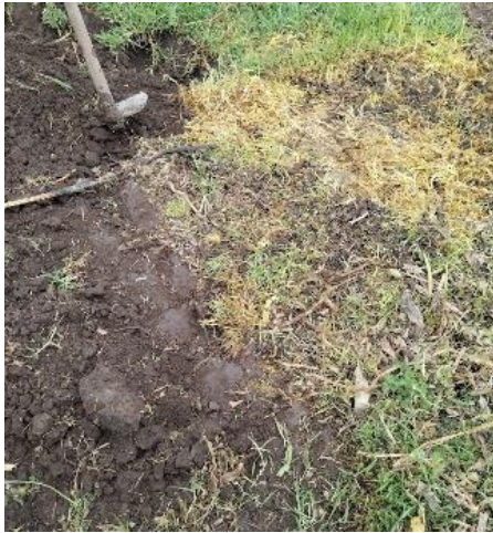
Figura 1: Preparación del lugar de trabajo
